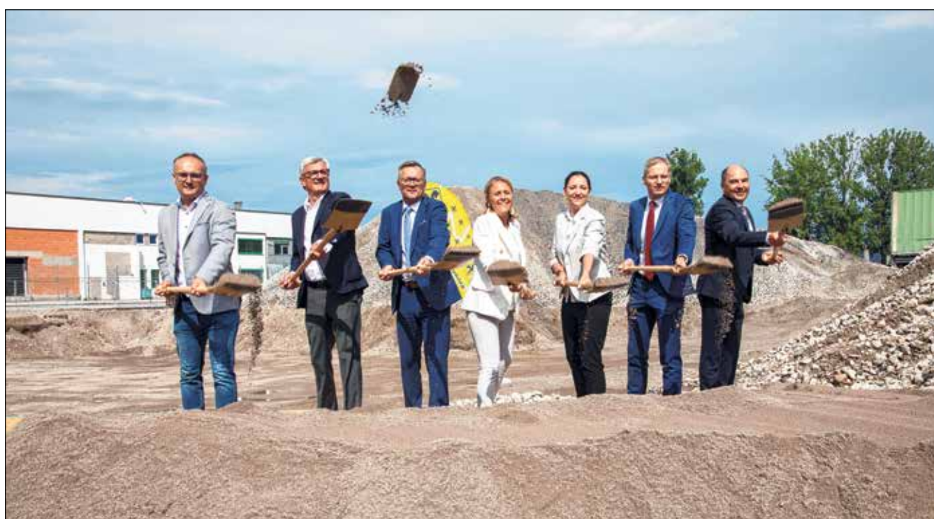
Spatenstich für das neue Zentrallager des Raiffeisenverbands Salzburg: Den Spaten in der Hand, die Zukunft im Visier: Andreas Stallinger (Schmid Baugruppe), Bürgermeister Harald Preuner, RVS-GD Heinz Konrad, Bürgermeister-Stv. Barbara Unterkofler, Anna Doblhofer-Bachleitner (RVS), Andreas Derndorfer (RVS) und Wolfgang Schröcker (Vertriebsleiter Lagerhaus).
